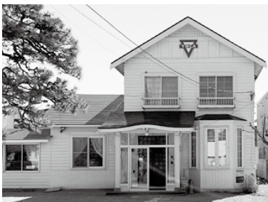
函館YWCA会館。改修の様子は地元新聞でも取り上げられた
