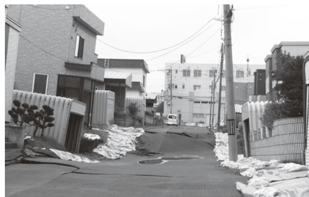
一見分かりにくいですが、液状化現象により地盤沈下が進み、道路は激しく陥没。民家が傾いている(札幌市清田区里塚)
